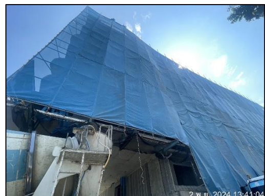
ภาพที่ 3 ผ้าใบกันฝุ่น Mesh Sheet
