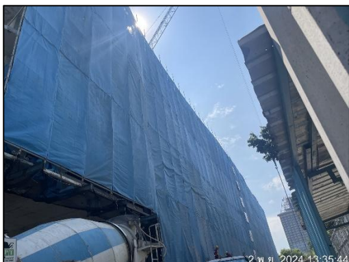
ภาพที่ 3 ผ้าใบกันฝุ่น Mesh Sheet
